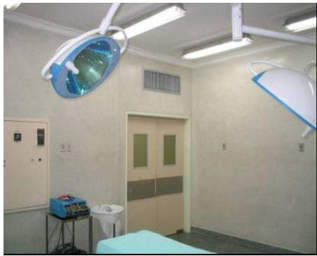
Figura 8 - Detalhes do difusor e da grelha de retorno.
