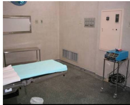
Figura 8 - Detalhes do difusor e da grelha de retorno.
