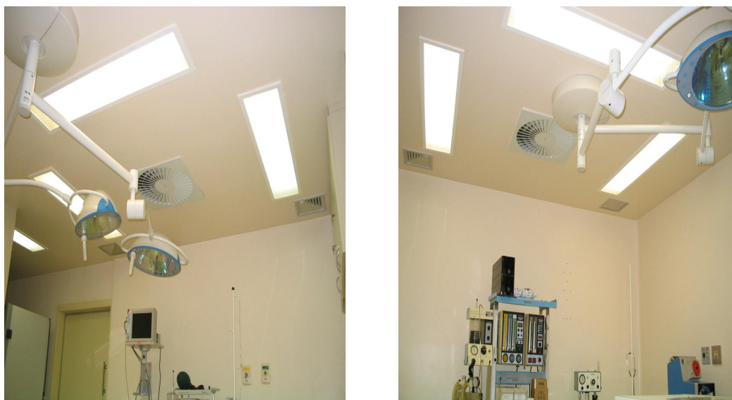
Figura 11 - Detalhes dos difusores e das grelhas de retorno.
